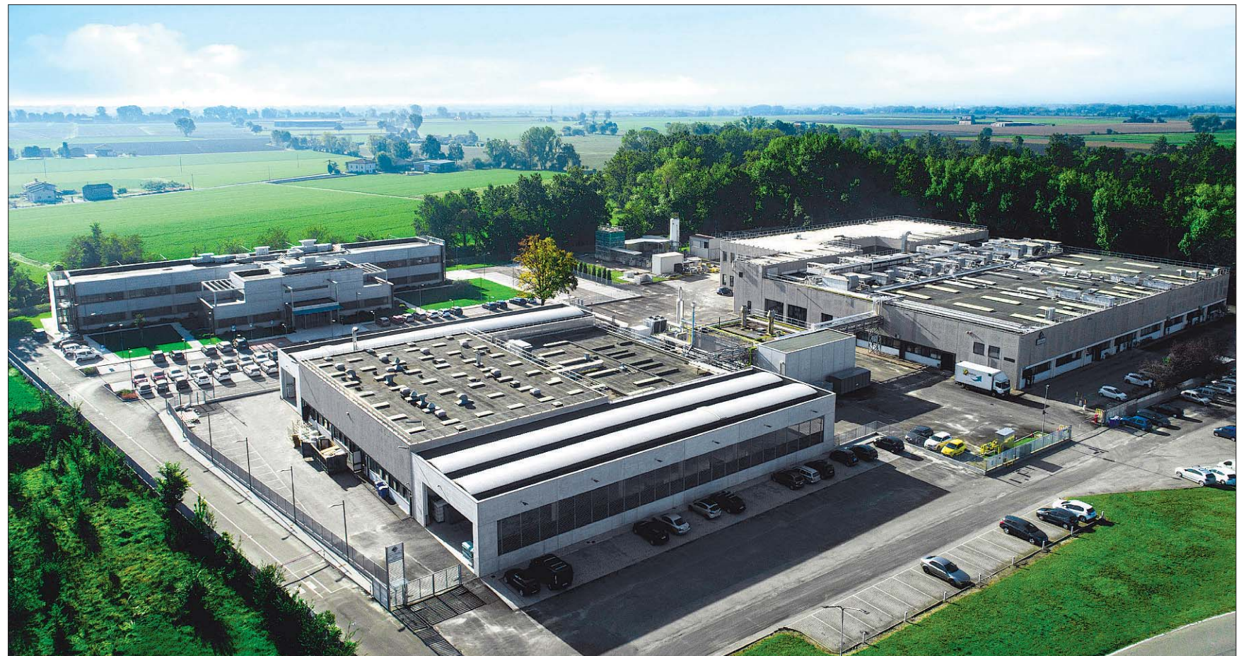
Un panoramica dall'alto dello Stabilimento di lavanderia industriale
